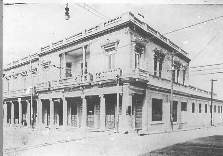
CON MOTIVO DE NUESTRO CONCURSO SOBRE "MUNDIAL".—Un ángulo de la fachada este, que ocupa la gran Litografía y Fábrica de cajas de cartón de los Sres. Estrugo y Maseda, en la Calzada de Belascoain.—(Fot. de Pijuan y Martínez).
